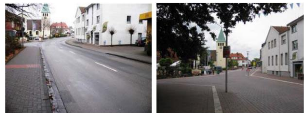
南側交差点 (整備前)
