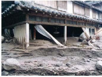
写真-4 雲仙普賢岳の噴火による火山灰を含んだ土石流で被害を受けた家屋
