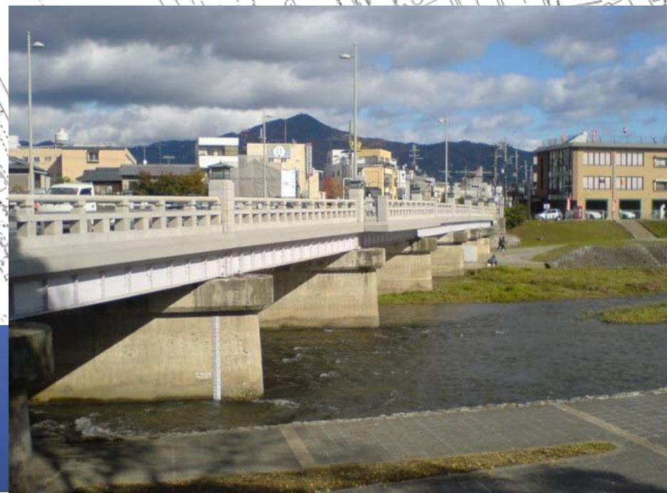
斜橋：橋脚がずれて見える
