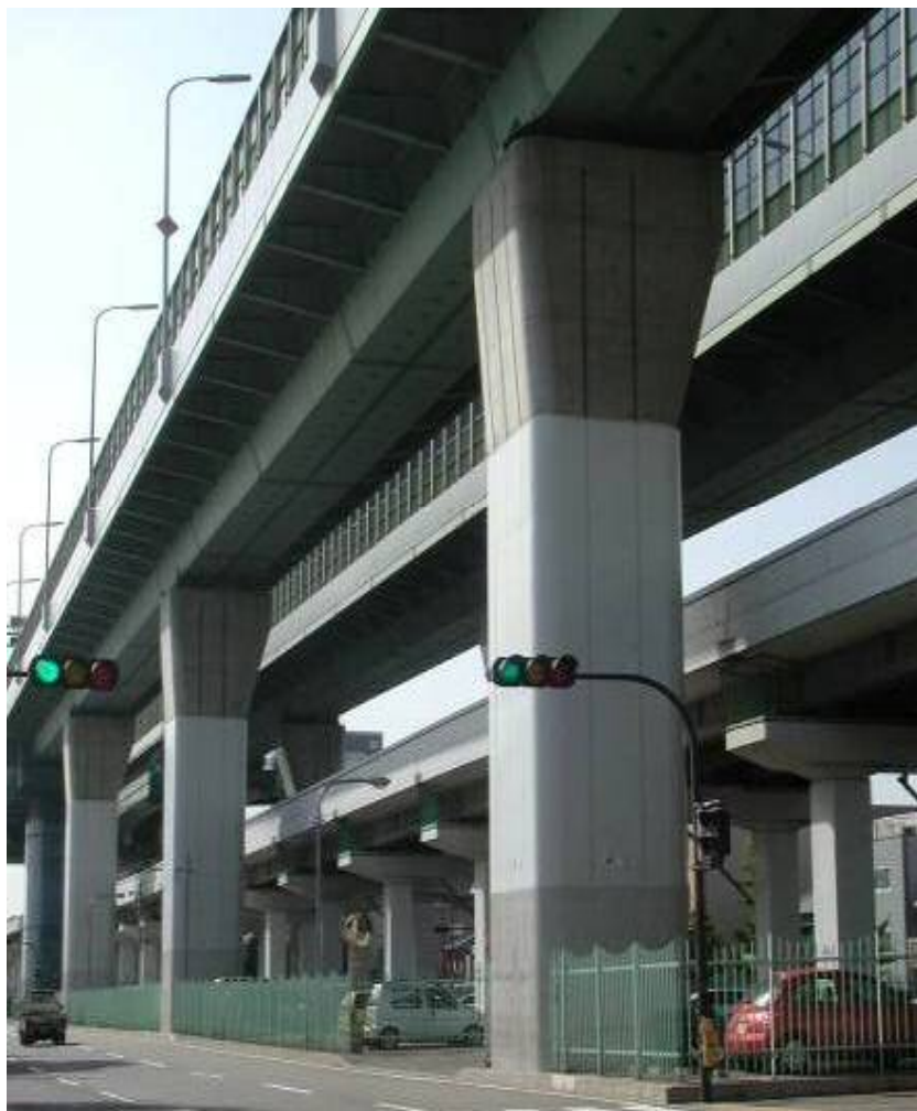
阪神高速道路の橋脚
