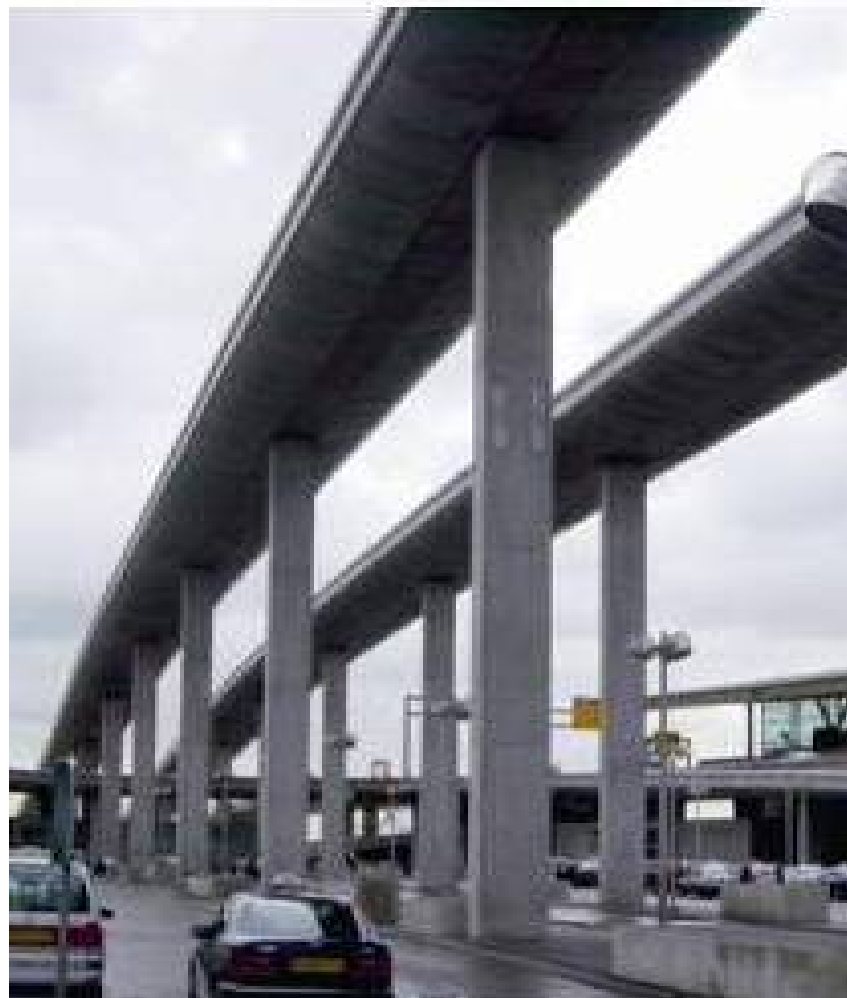
シャルル・ド・ゴール空港のアクセス道路の橋脚
