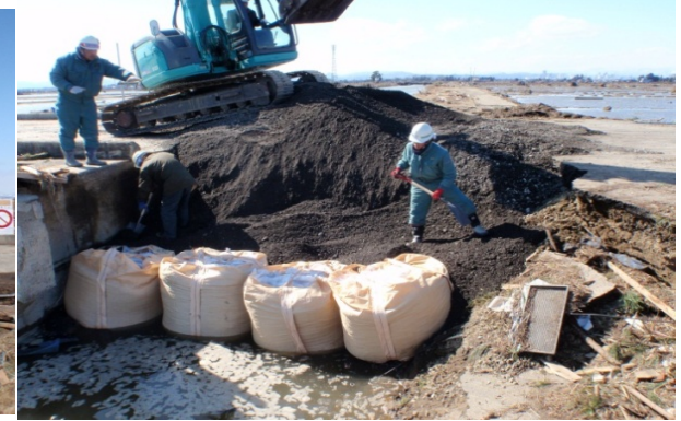
道路橋の復旧: 県道塩釜巨理線
